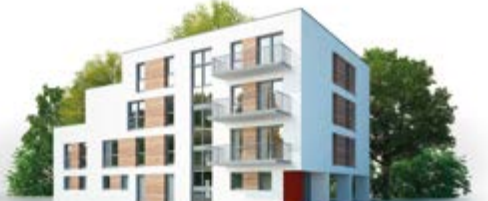
Maison à quatre logements
