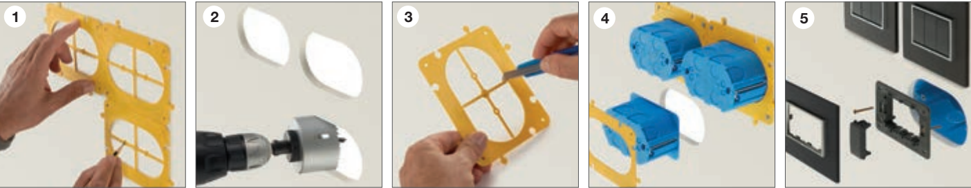
1. et 2. Utiliser l'accessoire ( V71573 ) comme gabarit pour un perçage de précision. 3. Avec un cutter classique ou des ciseaux d'électricien, enlever la grille centrale. L'accessoire s'adapte à la boîte et peut servir de collier. 4. Après avoir positionné la boîte sur le trou, la fixer à l'intérieur de la cloison légère avec des vis pour placo-plâtre. 5. La boîte alignée avec le mur est invisible.
