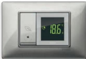
Elektronischer Touchscreen-Thermostat und zentralisierte Taste für die Aktivierung der Temperaturregelung im Komfortmodus.
